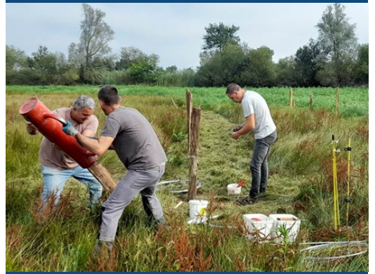
Pose des piliers des exclos à l'aide d'une tarière
