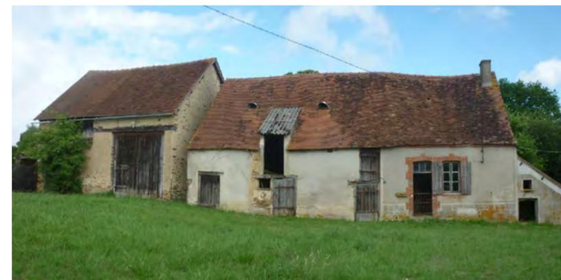
Ancienne ferme à la Chaume, Parnac. La pierre de construction est essentiellement du gneiss, ici recouverte d'enduit à la chaux. La brique est souvent présente autour des ouvertures.
