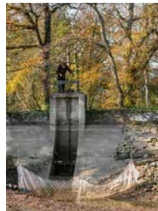
Bonde de l'étang de Grand Mez (Ménécaze). La partie de cette bonde en ciment, posée en 1962, est assemblée à une crémallière en fonte. Elle est actionnée au moyen d'une vis depuis le sommet de la digue.
