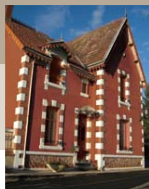
... et accompagnement avec un fond de façade dans le même esprit
