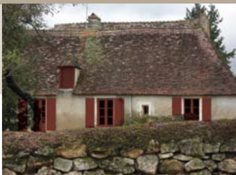
Menuiseries rouges, couleur traditionnelle en accord avec le ton des tuiles qui crée un ensemble coloré chaud pour la façade
