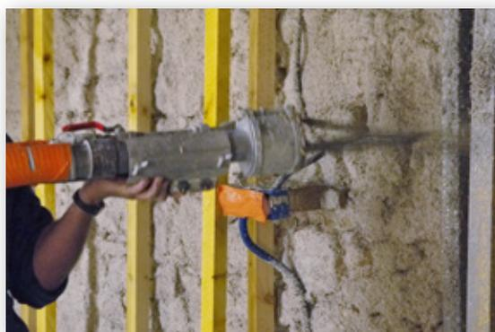
Projection d'un enduit isolant (béton chaux-chanvre).
