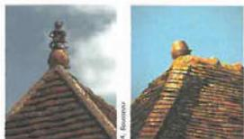
Dans quelques communes riveraines de la Creuse ou plus au sud, on observe de nombreux arêtières constitués d'une largeur de tuiles plates, scellées à plat en recouvrement.
