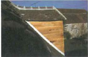
La jonction entre la toiture et les jouées est faite par un solin de mortier, recouvrant aujourd'hui des noquets de zinc pour l'étanchéité.
