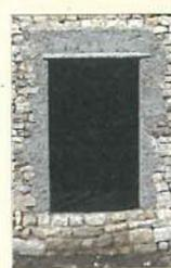
Il faut éviter d'employer le béton. En dehors du résultat visuel, il est trop rigide par rapport au corps de la maçonnerie et entraîne des fissurations.
