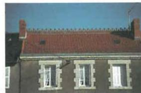
Au XIX<sup>ème</sup> siècle, on voit apparaître avec l'industrialisation, les tuiles mécaniques à emboîtement. Les finitions, faitages et rives étaient souvent décoratifs et les tuiles, ornées de losanges.
