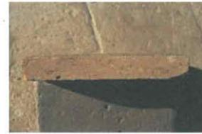
La fabrication artisanale au moule, le triage et le malaxage assez grossier de la terre produisaient des carreaux veinés dans la masse.
