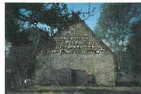
Le ciment est utilisé pour toutes sortes de bricolages en milieu rural. Il n'est pas rare que les restes d'une gâche de ciment soient étalés sur un bas de mur pour "tassainir". Ces réparations, catastrophiques sur le plan visuel et très nuisibles à la santé des murs, sont de plus difficiles à éliminer sans dégrader la pierre.
