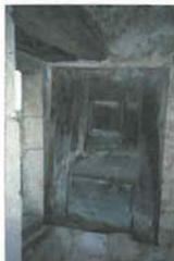
Les fenêtres étaient occultées, à l'origine, par un simple battant de bois qui se logeait dans une feuillure de la maçonnerie.
