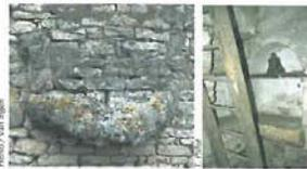
L'évier proprement dit est une large dalle de pierre, posée sur la largeur du mur. Elle est vaguement égarée, pour former une surface plane, avec un léger rebord à l'intérieur. L'écoulement fait une saillie plus ou moins forte à l'extérieur.
