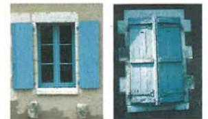
Pour respecter une spécificité des pratiques constructives locales, le volet ouvert doit présenter sa face lisse. Les barres et les pentures sont placées sur la même face.
