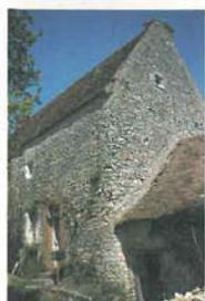
Dans quelques bâtiments très anciens les murs sont montés sans chaînages d'angles. Les angles sont alors arrondis ; c'est la maçonnerie qui tourne.
