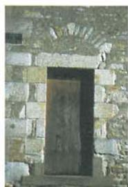
Au-dessus des linteaux, des arcs de décharge en pierre ou en brique reportent le poids de la maçonnerie sur les jambages.
