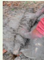
digne de ce nom. Au programme : réalisation et pose de fusées de torchis, une technique ancienne qui consiste à placer en rangée des fusées de bois, enroulées d'un mélange de torchis, pour former des planchers. À l'origine, il y avait plus de 500 fusées... de quoi s'initier à une technique ancienne ! Chantier animé par l'association Pierre qui roule et Marianne Caradec (PNR Brenne), ouvert de 5 à 15 personnes.
