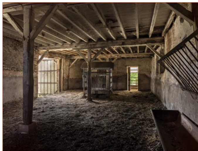
Etable des Gagnerons et sa charpente (ci-contre) sur poteaux datée des environs de 1670 (© Vanessa Lamorlette-Pingard, SPI-CVL)
