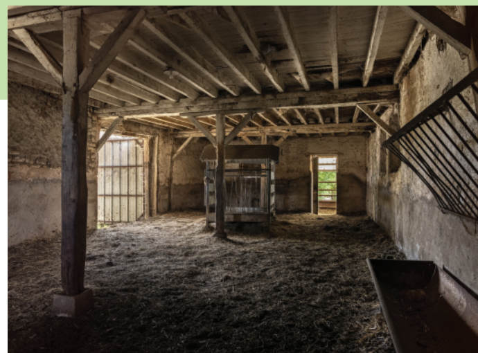
Poteaux engagés dans les murs et soutenant la charpente ; ceux du milieu ont été ajoutés vers 1911.
