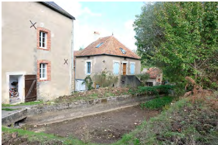
Le bief du Moulin, à sec, en octobre 2019.
