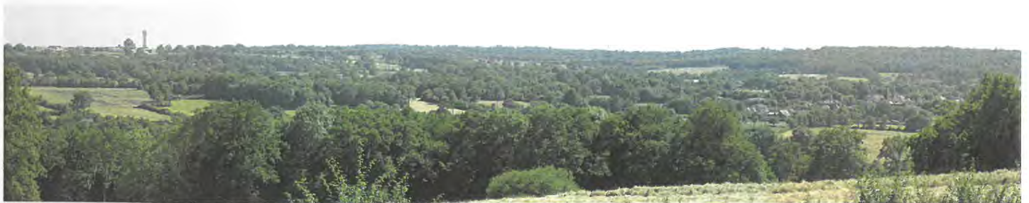
Vue panoramique depuis la route des Vignes-Madame en limite de Sacierges et Saint-Civran.
