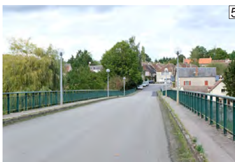
Vue en direction du centre-bourg de Fontgombault depuis le pont.
